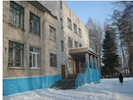
Voor de renovatie
