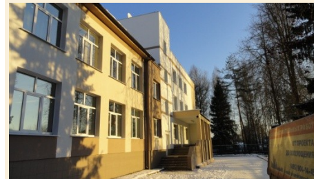
Na de renovatie
